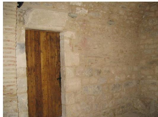
Fig. 8 - Élévations intérieures de la tour-clocher. Vestiges des parements intérieurs primitifs, interrompus par le percement de la porte de la tour d'escalier et surmontées par les maçonneries de la voûte.
