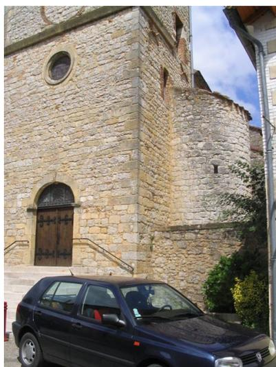
Fig. 7 - Angle sud-ouest de la tour-clocher. La tourelle d'escalier est accolée contre les maçonneries de la tour qui sont antérieures.
