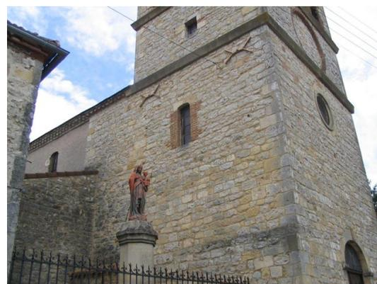
Fig. 5 - Élévation nord la tour-clocher. La chaîne d'angle de gauche délimite une construction rectangulaire désaxée par rapport au chevet et dont le plan ne correspond plus à celui de la tour-clocher moderne.
