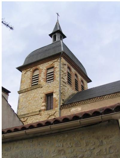
Fig. 6 - Élévation sud la tour-clocher. Le clocher actuel résulte de l'amputation d'un édifice antérieur comme le montrent les arrachements visibles au-dessus de l'égout de la nef.
